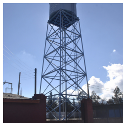
Agua de pozo del APR Las Calderas
